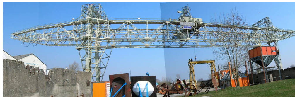
Portique roulant Chalon-Sur-Saône
